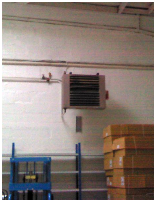
Fig.6 : Radiateur suspendu dans la salle polyvalente.
