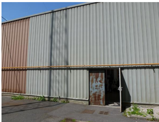
Figure 1 : vue du mur sud extérieur du dépôt
