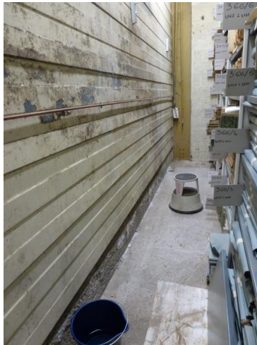
Figure 2 : vue du mur sud intérieur du dépôt
