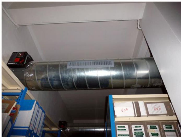
Fig.3 : Gaine de renouvellement et d'évacuation de l'air.
