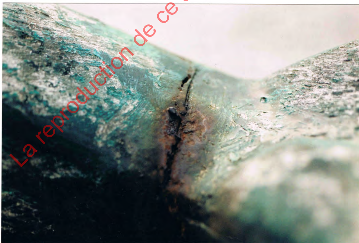
Fig.61: Fissure profonde et trace d'oxydation de l'armature.
