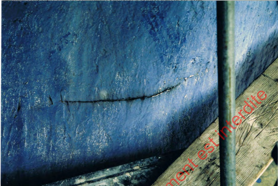
Fig.29: Fissure provoquée par un affaiblissement du stratifié au niveau d'un point de contact BR, exp. Sud
