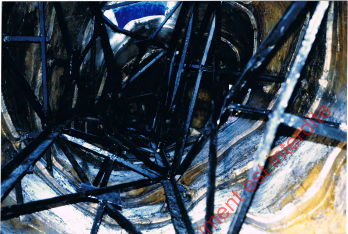
Fig.25: Armature métallique interne du personnage JBR
