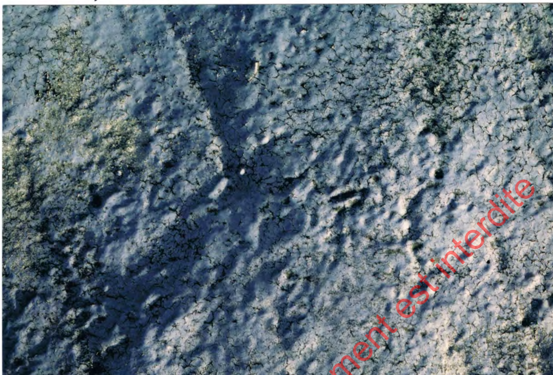
Fig.18: Micro-craquelures avec micro-organismes JBR, exp. Ouest
