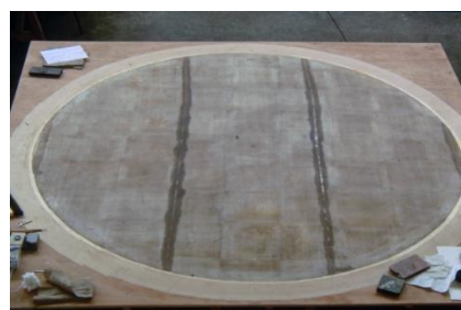
Photo106, La sincérité et la foi du serment, vue générale, imprégnation locale au niveau des coutures arasées et des anciens accidents.
