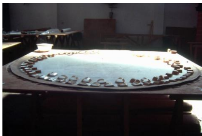
Photo121 , Justice tenant les tables de la loi, vue générale, mise en place des tirants.
