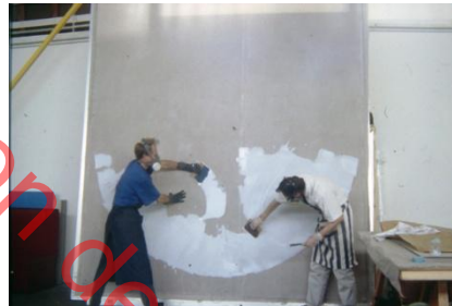
Photo 170, Préparation de la toile de doublage, encollage de Plextol B 500 épaissi.
