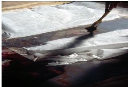
Photo 164, Pose d'un Boloré de protection.
