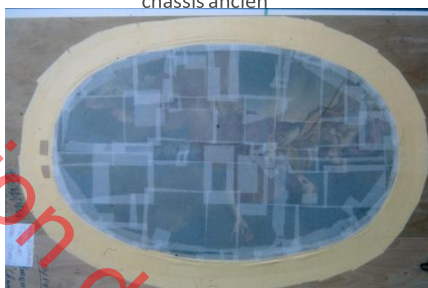
Photo26 , Pomone, vue générale, protection et mise sous tirants d'urgence.
