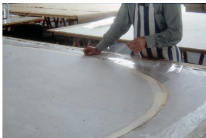
Photo181, Dégagement des matériaux de mise en oeuvre du doublage.
