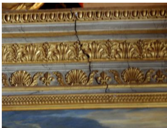
Figure 4 : Fissure transversale de la corniche.
