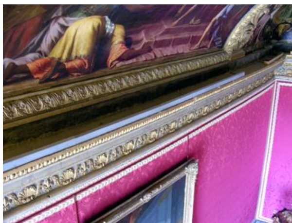
Figure 1 : Cintrage et déformation de la corniche
