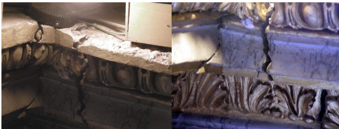
Figure 2 : Fissures au niveau de la corniche angle nord-est.
