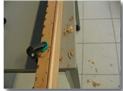
■ Fig 14 Mise en place du système S.T.A.R® sur un des châssis du triptyque – création d’une rainure. © Alain Roche.
