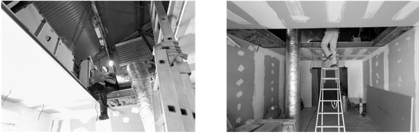
*Figure 90 : Travaux de remise aux normes climatiques de la salle de la cuverie, doc Fondation Clément.*
