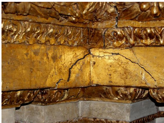
Fig. 9,10 Fissures actives
