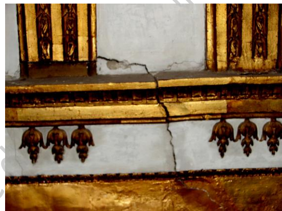
Fig. 9,10 Fissures actives
