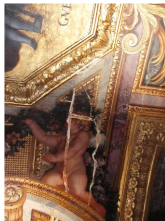
Fig.6, 7, 8 : Fissures stabilisées
